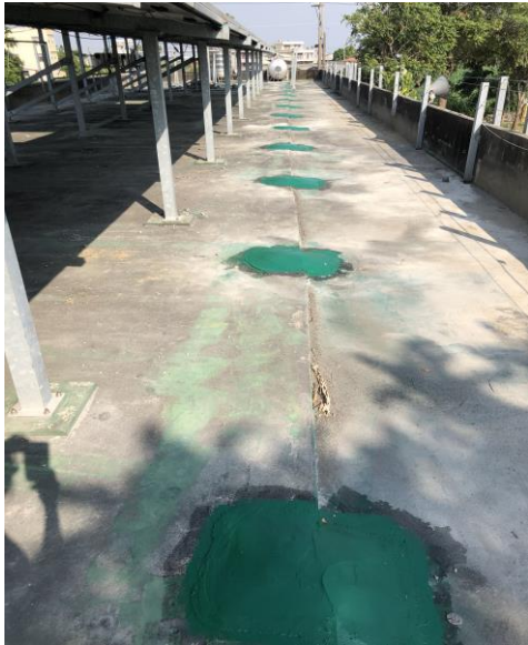
南棟校舍 2 樓柱頭補強工程
