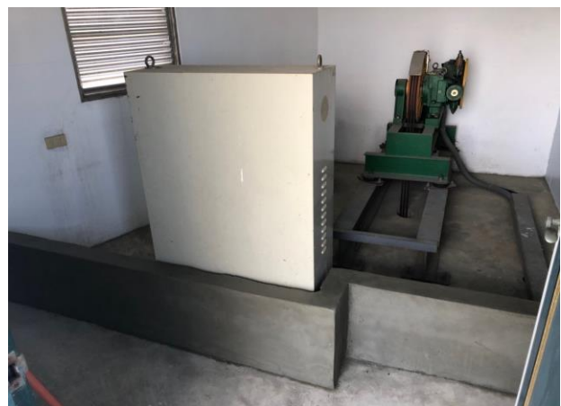
電梯間防水工程
